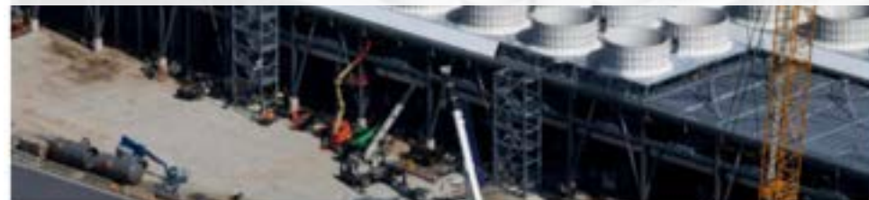
建設中のマイクロソフトのデータセンター（米ウィスコンシン州マウントプレザント）。第1期工事は2026年に完成予定
